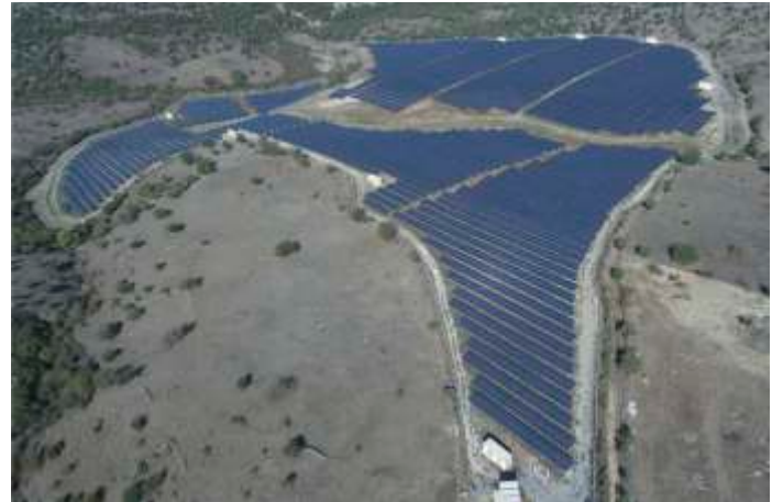
MANİSA / YUNUSEMRE / AKÇAKÖY 8.554 kWp
