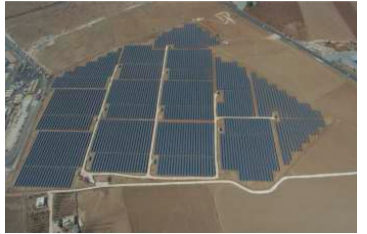
ŞANLIURFA / MERKEZ / KARATAŞ 15.444 kWp
