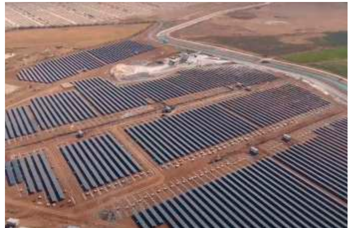
ŞANLIURFA / KARATAŞ 12.040 kWp
