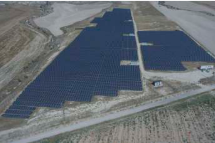
ANKARA / AYAŞ 5.479,65 kWp
